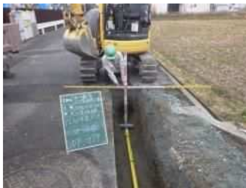
ガス管布設工事（サーラエナジー）
